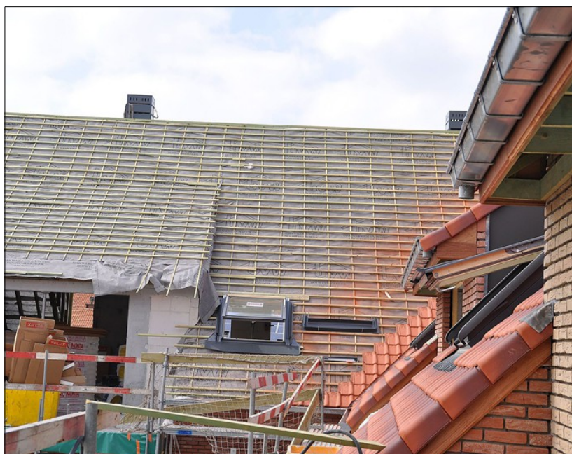
Men diende af en toe de spanten aan te passen aan de plaats van de Kombitube
